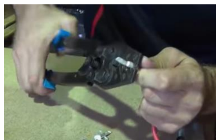
Figura 10 – Crimpagem do Conector.
