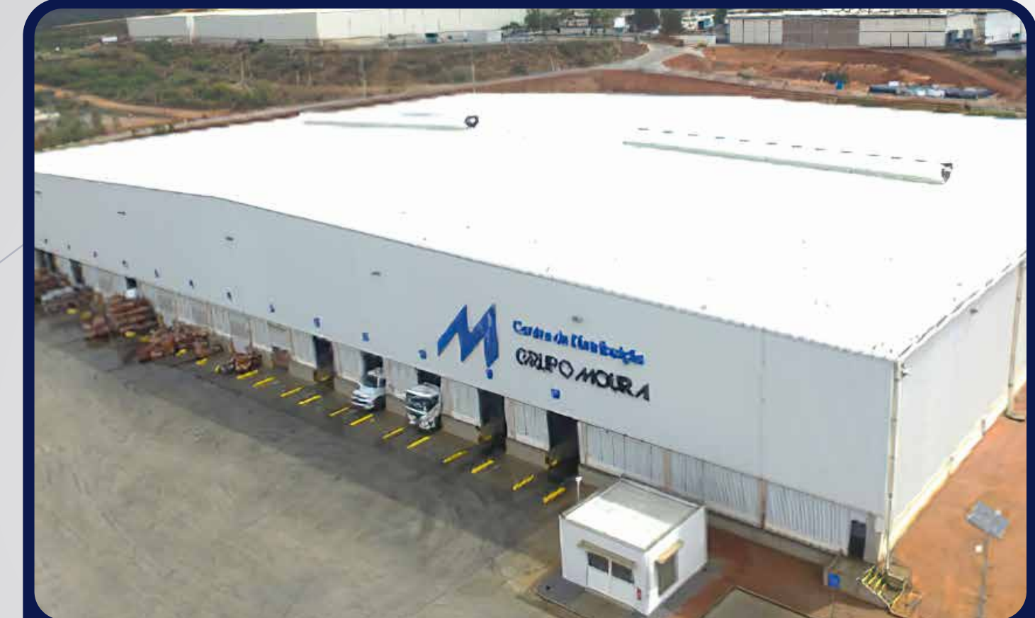
Centro de Distribuição
