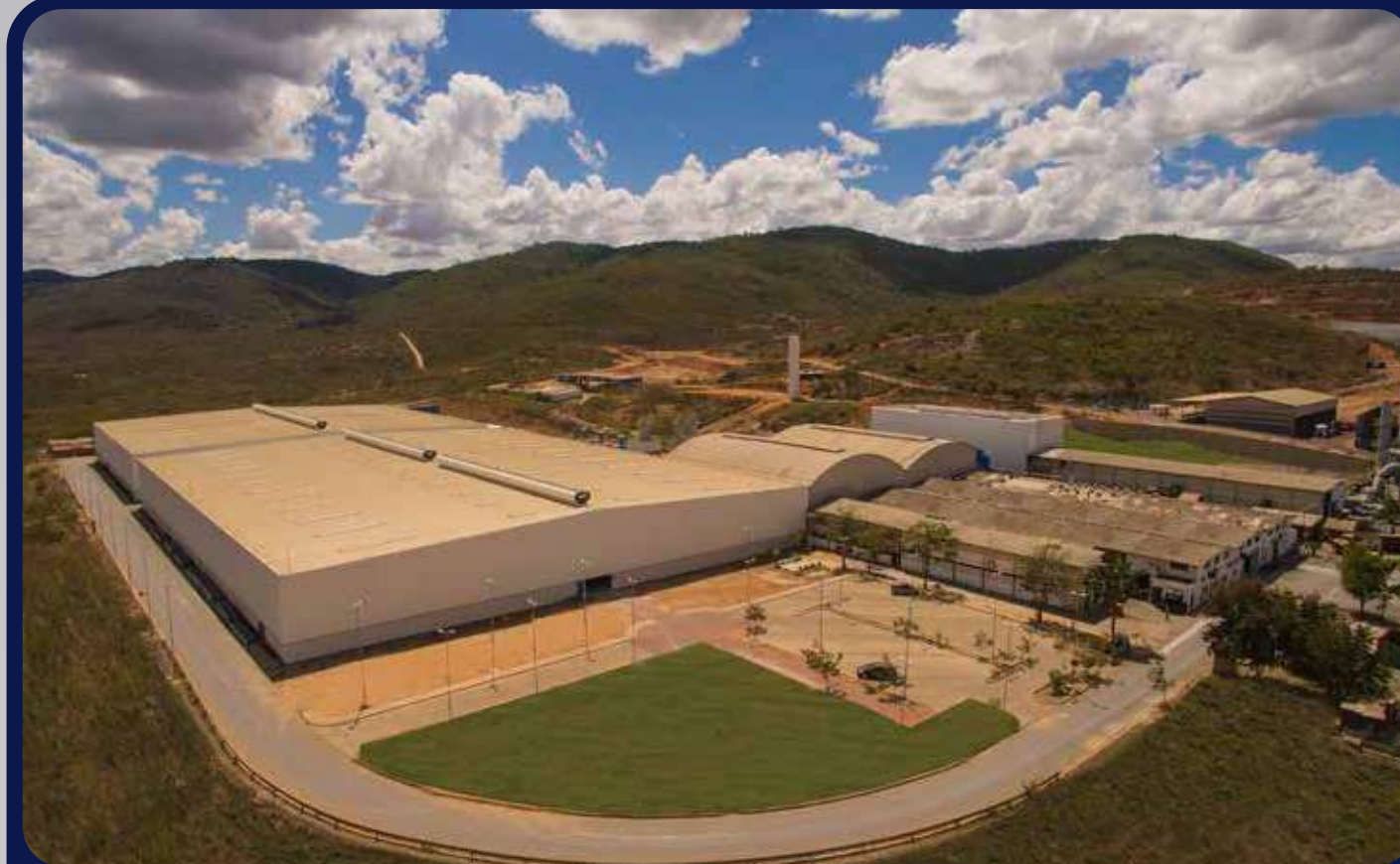
Planta de Baterias Industriais
