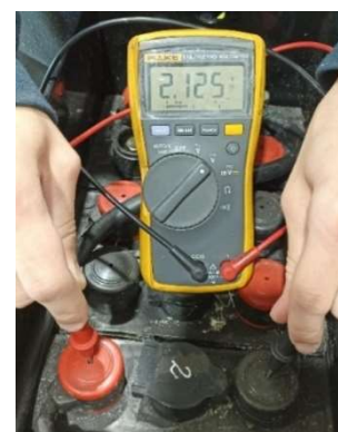
Figura 22 – Medição de tensão de um elemento.
